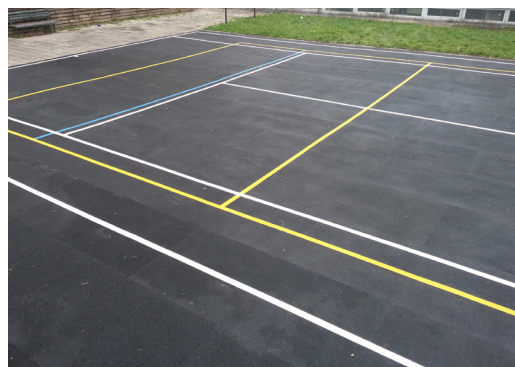
STAV PO REVITALIZACE
